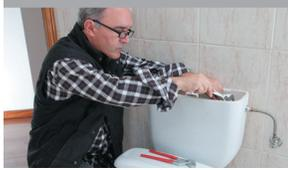
在马桶水箱中滴入几滴食用色素，以检查是否漏水。如果马桶中的水在15分钟后改变颜色，则表明有漏水。
