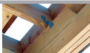
使用防飓风夹将屋顶固定在墙壁上。确保门廊所有支撑柱的顶部和底部都已锚固好。
