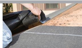
在整个屋顶板上铺设两层连续衬垫或防水冰水屏障，并为瓦片加装额外紧固件（间距更小）\*。
