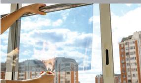
在窗户上贴一层4毫米厚的安全膜或安装防护百叶窗，以抵抗撞击、放置破碎。遵循制造商的说明以获得窗户保修。
