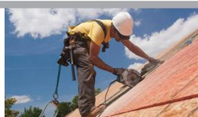
确保您的屋顶和墙壁有完整、适当的护墙板，以便在强风中有更大的抗剪强度和稳定性。
