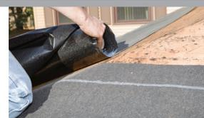
Posez deux sous-couches continues ou protections imperméables à l'eau et à la glace sur l'ensemble du toit-terrasse, ainsi que des fixations supplémentaires (plus rapprochées) pour les bardeaux\*.
