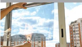
Appliquez un film de sécurité de 4 mm d'épaisseur sur vos fenêtres ou installez des volets de protection pour rendre vos fenêtres résistantes aux chocs et aux éclats. Suivez les instructions du fabricant pour assurer la couverture de la garantie des fenêtres.
