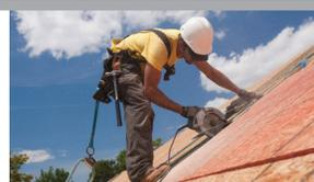
Veillez à ce que votre toit et vos murs soient complètement et correctement recouverts d'un revêtement afin de renforcer la résistance au cisaillement et la stabilité en cas de vent violent.
