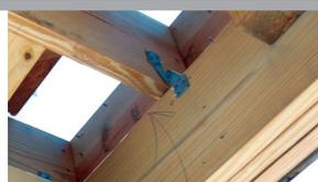
Utilisez des clips anti-ouragan pour fixer le toit aux murs. Veillez à ce que tous les poteaux de soutien des porches soient ancrés en haut et en bas.
