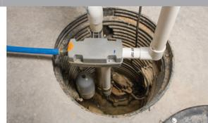
Si vous disposez d'une pompe de puisard et/ou d'un dispositif anti-refoulement, vérifiez qu'ils fonctionnent et nettoyez-les à chaque printemps.
