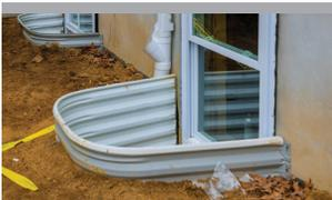
Installez des soupiraux de manière à ce que leur sommet se trouve à 10-15 cm au-dessus du sol et remplacez-les par des fenêtres résistantes à l'eau.
