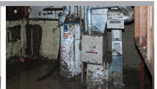
Élevez vos équipements (par exemple, le four, le réservoir d'eau chaude) en les installant sur une plateforme élevée ou en construisant une pièce de service à un étage supérieur.
