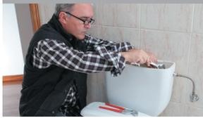
Compruebe si hay fugas en los inodoros poniendo unas gotas de colorante en el tanque. Si el agua del recipiente cambia de color después de 15 minutos, hay una fuga.
