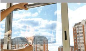
Aplique una película de seguridad de 4 mm de grosor a sus ventanas o instale persianas protectoras para que sus ventanas sean resistentes a los impactos y a las roturas. Siga las instrucciones del fabricante para asegurar que las ventanas están cubiertas por la garantía.
