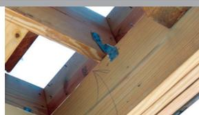
Use clips para huracanes para fijar el techo a las paredes. Asegúrese de que todos los postes de soporte en los porches estén anclados en la parte superior e inferior.
