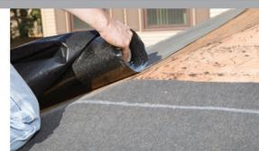
Coloque dos capas de contrapiso continuo o una protección impermeable contra el hielo y el agua en toda la cubierta del techo y fijaciones adicionales (espaciadas a poca distancia entre sí) para las tejas\*.
