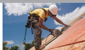
Asegúrese de que el techo y las paredes están completa y adecuadamente revestidos para aumentar la resistencia al cizallamiento y estabilidad en caso de viento fuerte.
